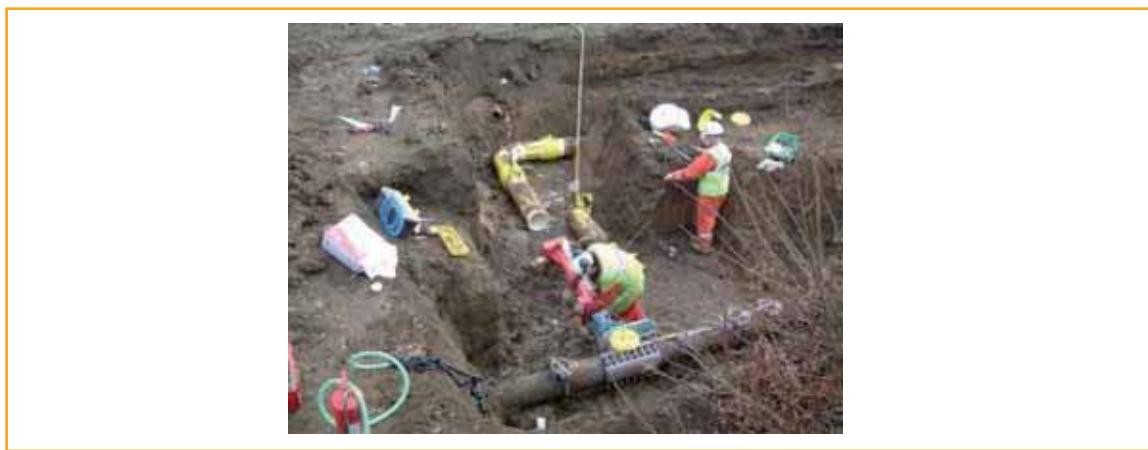
Figura 3. Condiciones típicas del emplazamiento para la instalación de los tubos de plástico / Figure 3 Typical site conditions for installing plastics pipes.
