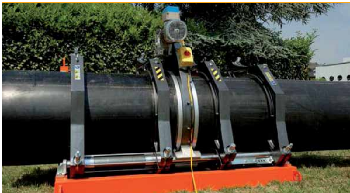
Figura 1. Soldadura a tope por fusión de tubos de PE en campo / Figure 1 Butt fusion welding of PE pipes in the field.
